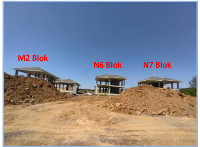
2. Etap Genel Görünüm
