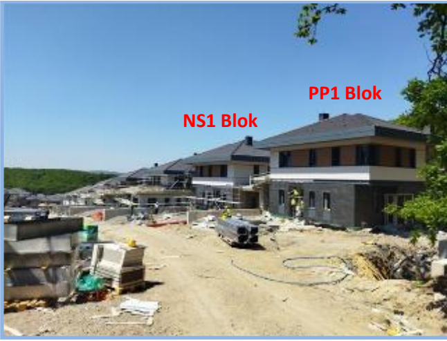
1. Etap Genel Görünüm
