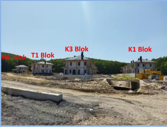
1. Etap Genel Görünüm
