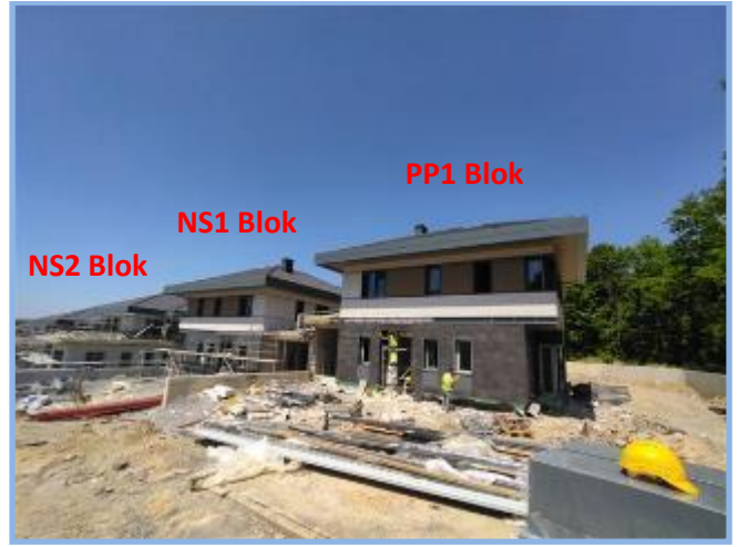
1. Etap Genel Görünüm
