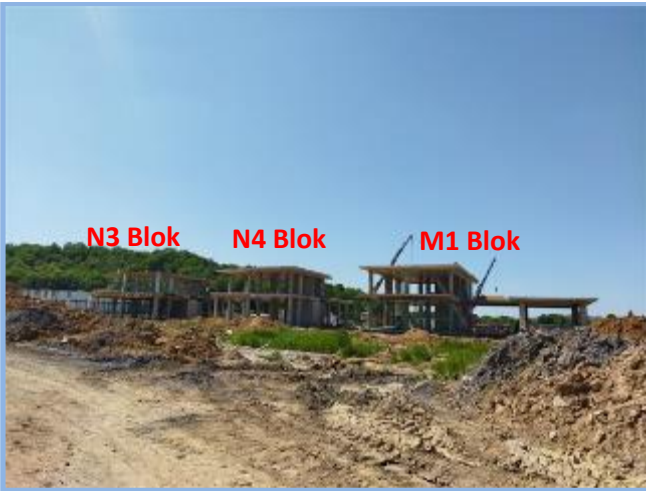
2. Etap Genel Görünüm
