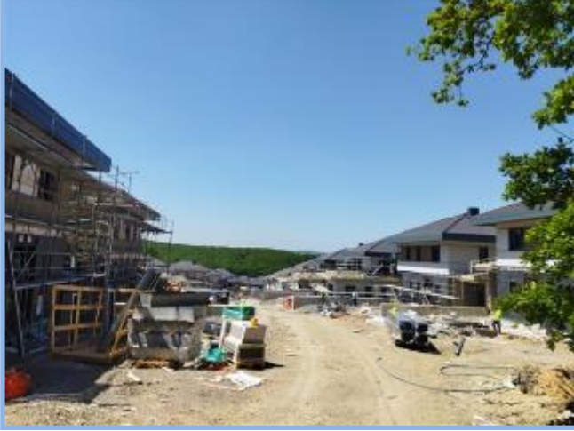
1. Etap Genel Görünüm
