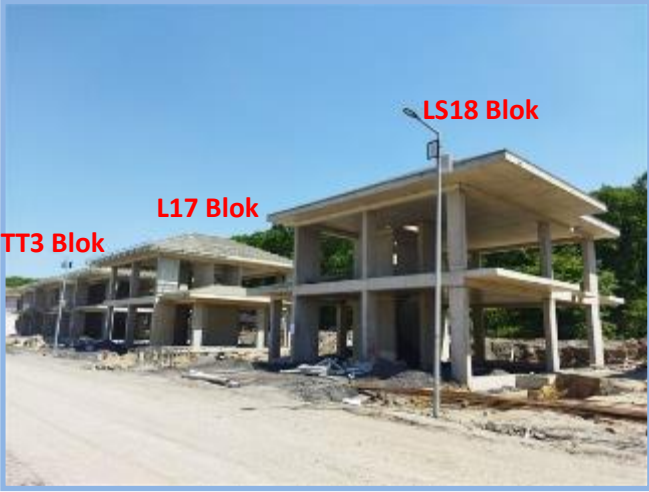
2. Etap Genel Görünüm
