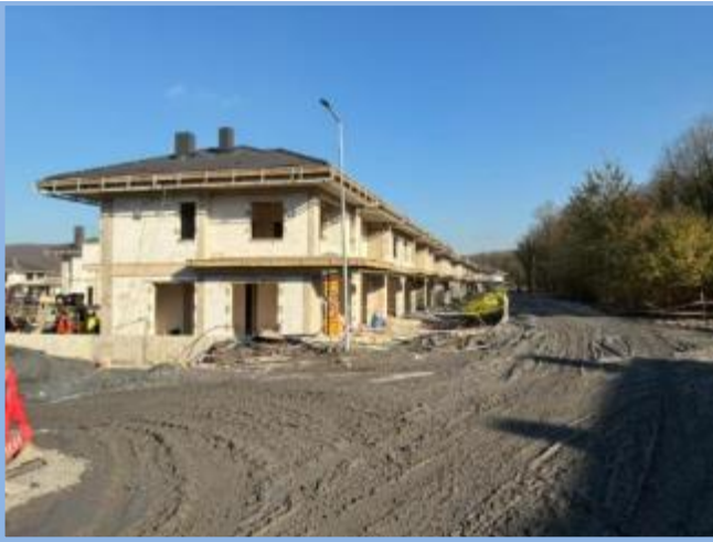
1. Etap Genel Görünüm
