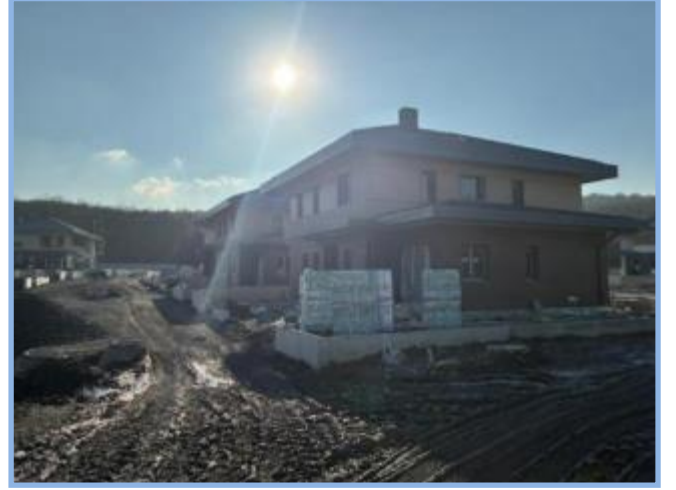
1. Etap Genel Görünüm
