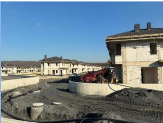
1. Etap Genel Görünüm
