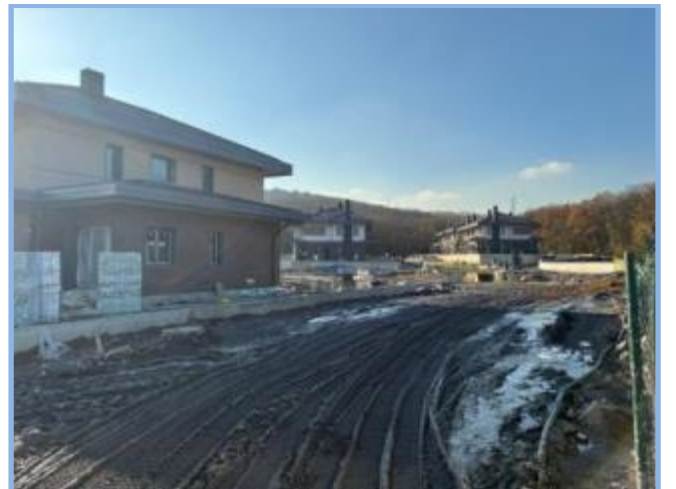
1. Etap Genel Görünüm
