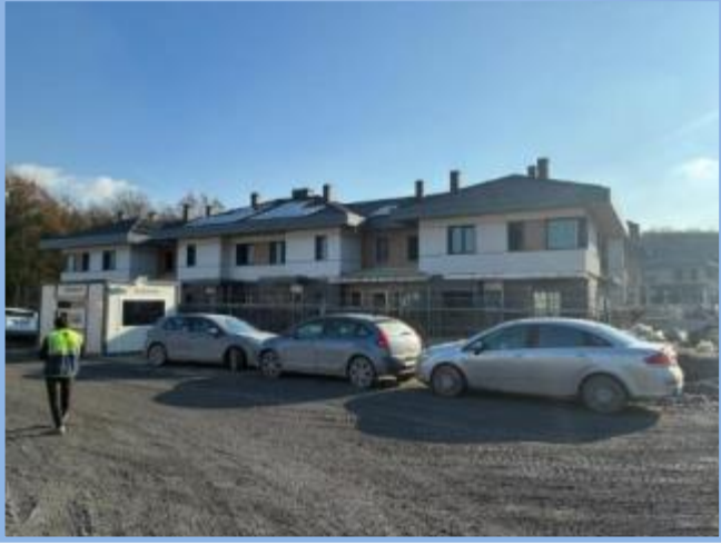
1. Etap Genel Görünüm
