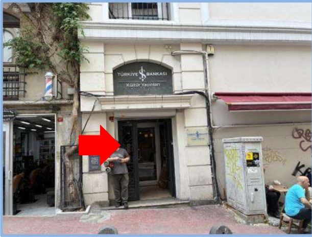
Meşelik Sk. Cephesi (No:2)
