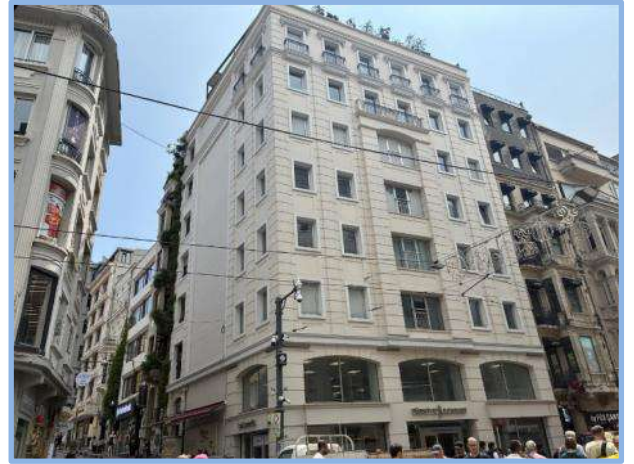
Değerlemeye Konu Bina (İstiklal Cd. Cephesi)
