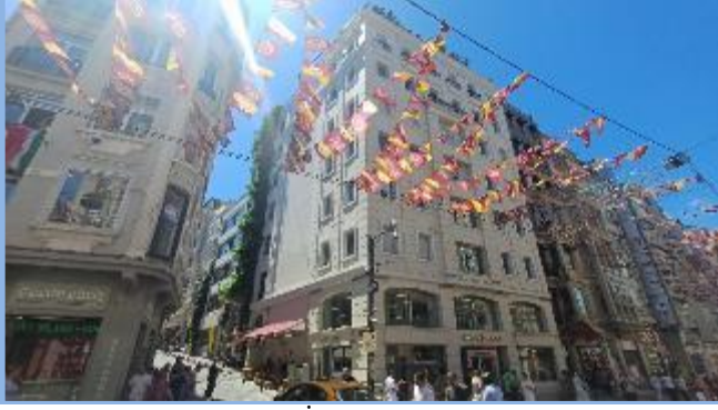
Değerlemeye Konu Bina (İstiklal Cd. Cephesi)
