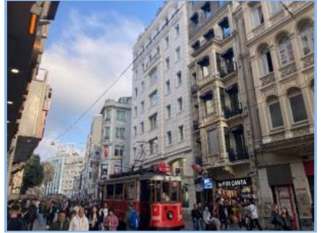
Değerlemeye Konu Bina (İstiklal Cd. Cephesi)
