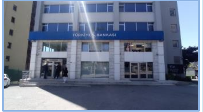
B Blok Görünümü (Tapu Kaydında C Blok)
